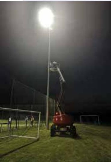
Les deux terrains de foot de la commune équipés d'éclairage ont été équipés de leds, afin de réduire la consommation d'électricité et d'augmenter la qualité d'éclairage pour les joueurs.
